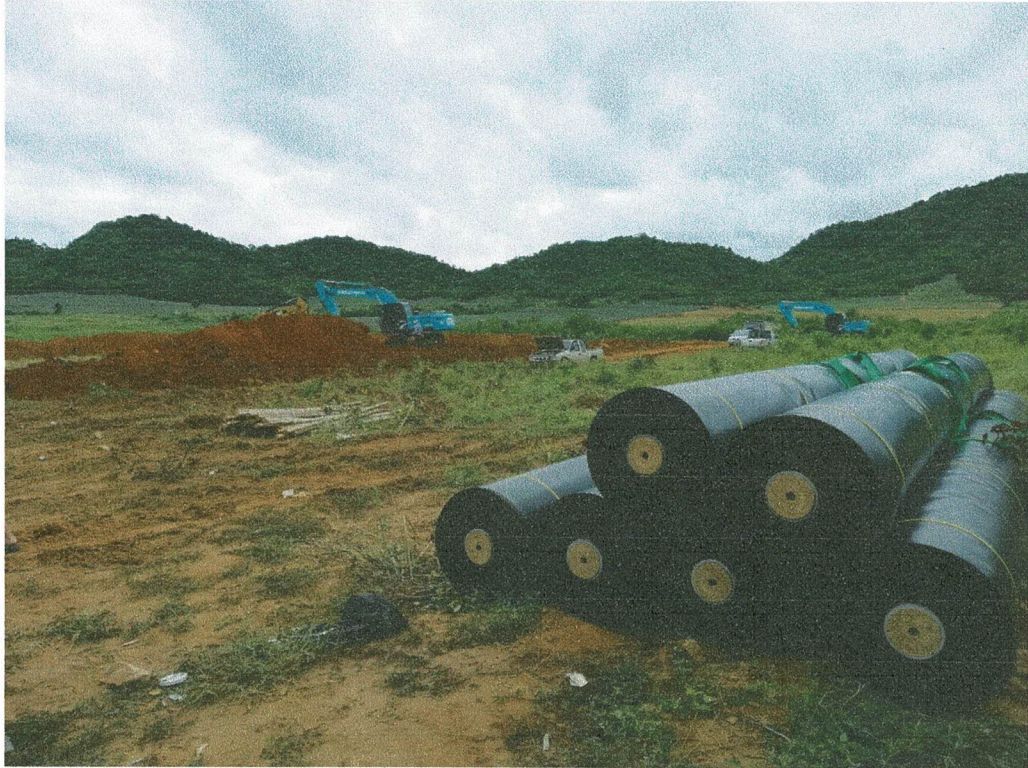
วัสดุสังเคราะห์ประเภทแผ่น โพลีเอทิลีนชนิดหนาแน่นสูง (High Density Polyethylene, HDPE) ขนาดความหนา 1.5 มิลลิเมตร ขึ้นไป เป็นผนังกันซึมและกันบ่อเพื่อป้องกันน้ำเสีย จากขยะลงสู่พื้นดิน
